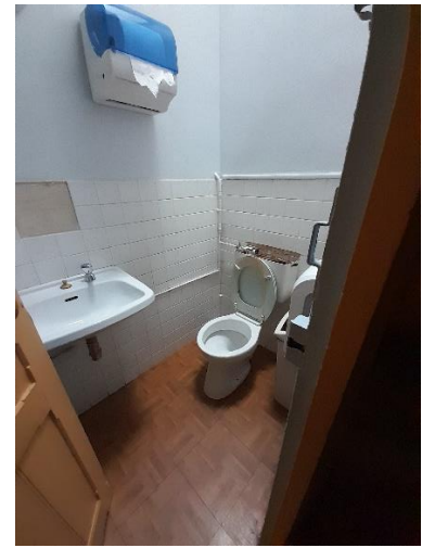
Sanitaire de la cellule de la cour d'assises
