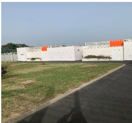
Bâtiment des unités de vie familiale
