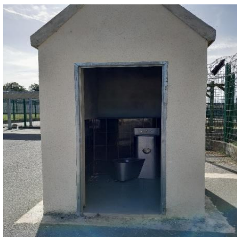
Toilettes dans la cour de promenade du bâtiment B
