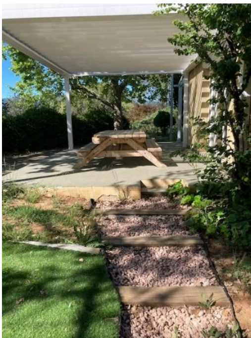
Petite allée menant au bâtiment de la restauration
