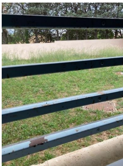
Vue rapprochée du barreaudage équipant les fenêtres
