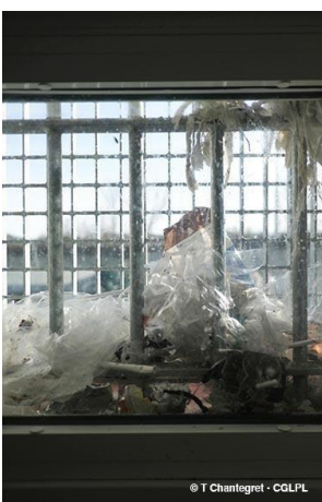
16 Fenêtre cellule disciplinaire
