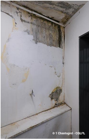
1 Coursive bâtiment A
