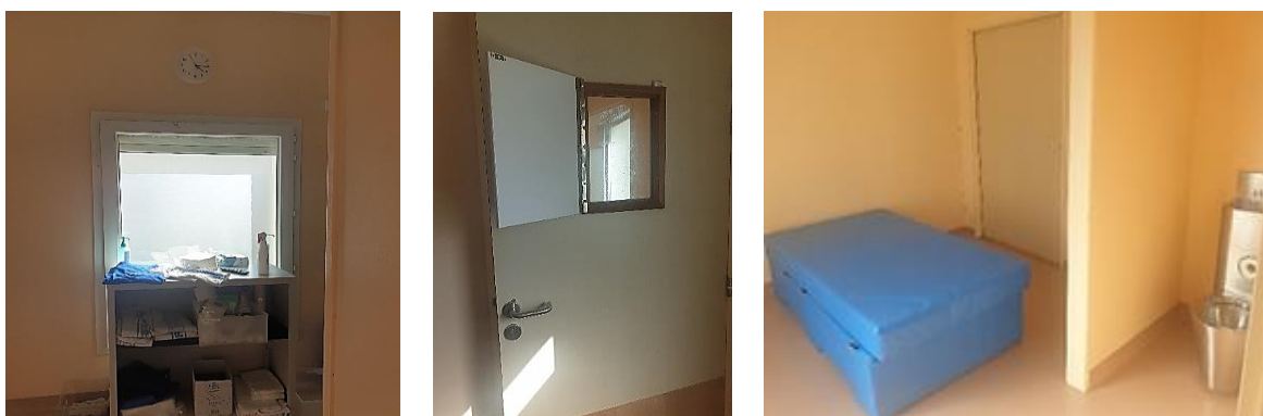
Sas, porte de chambre d'isolement, chambre
