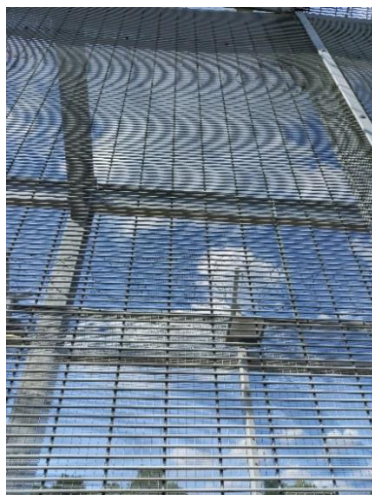
Grille et détecteur de mouvement, arrière des bâtiments
