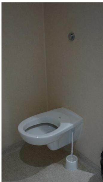
WC dans une chambre de l'unité Brévent
