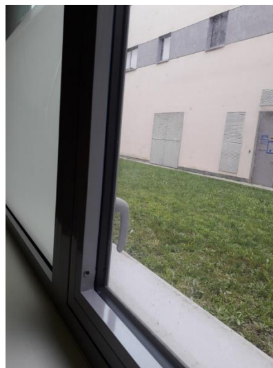
USM 1 : Fenêtre d'une chambre « fermable »
