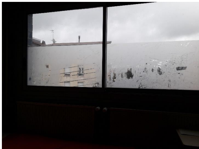
Fenêtre d'une des chambres
