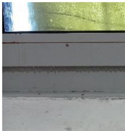
Suintement au niveau d'une fenêtre de cellule du QA
