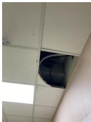
Le double plafond du couloir de G04
