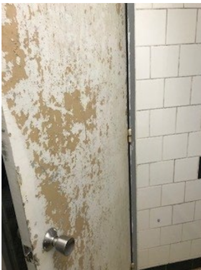
Porte d'accès au local des douches et WC
