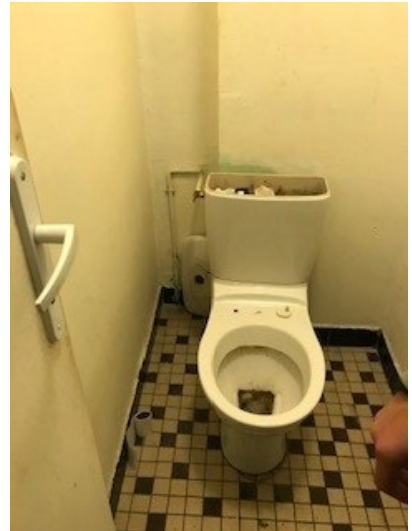
WC du 1 er étage
