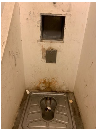
Toilettes et point d'eau – Cellule individuelle
