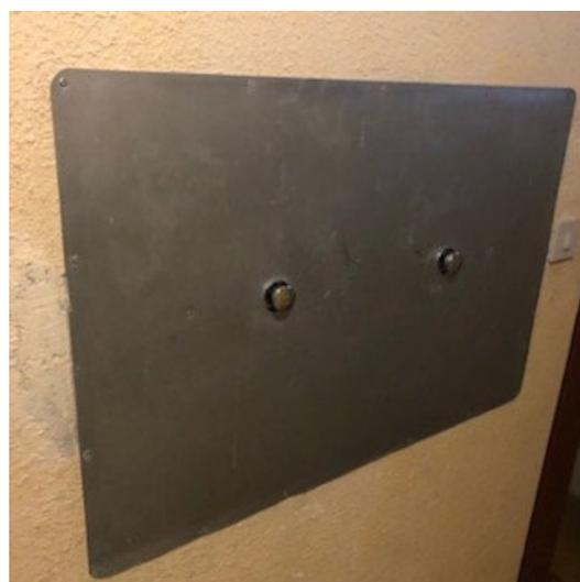
*Contrôle extérieur des chasses d'eau et de l'éclairage*
