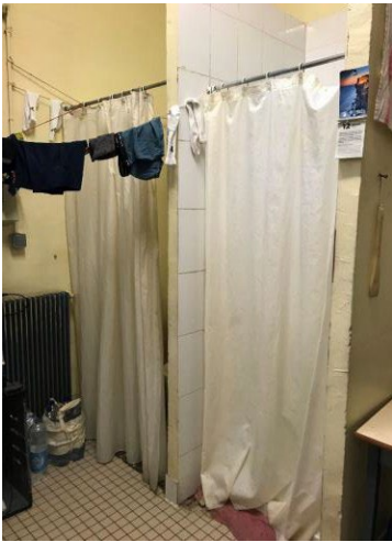
10 WC et douche cellule 116
