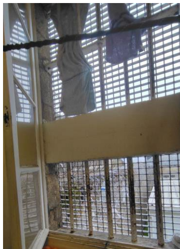
8 Caillebotis fenêtre cellule 116
