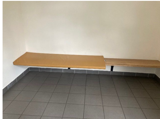
Matelas sur banc sous dimensionné
