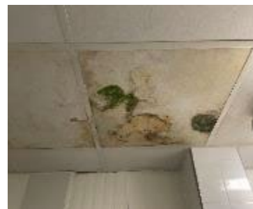
Vues de la cuisine et des tâches d'humidité sur le faux plafond
