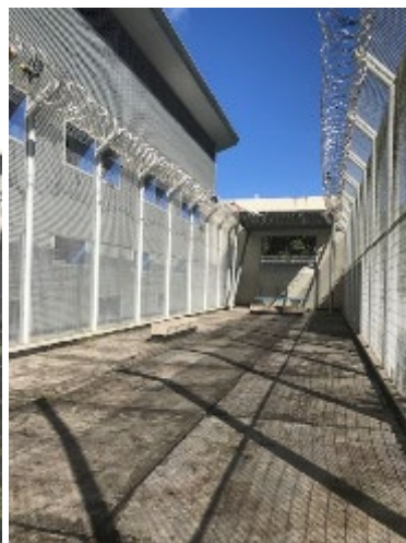
Vue de la cour de promenade
