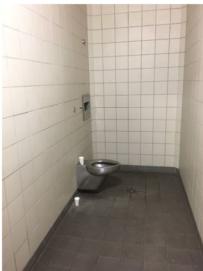
Salle d'eau commune avec douche et toilettes
