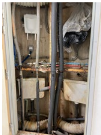
Gaines techniques entre deux cellules ; sous les sacs plastique pour contenir les fuites, le disjoncteur
