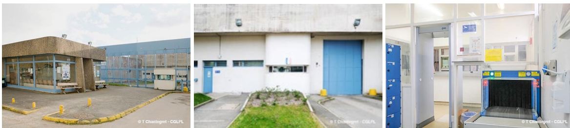
Grille d'entrée, vue du PCS et sas du PCS
