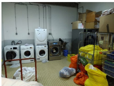
Vue partielle de la buanderie avec les machines
