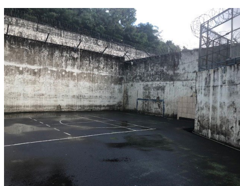
Vue du sol de la cour A
