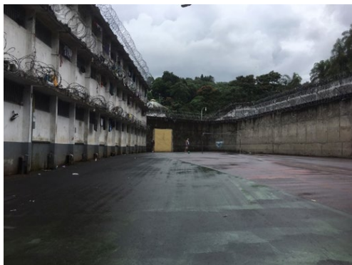
Cour de promenade du bâtiment B
