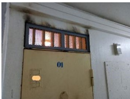
Porte de la cellule d'isolement
