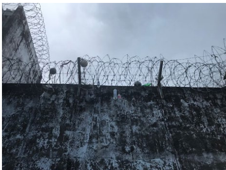
Mur de séparation entre les cours
