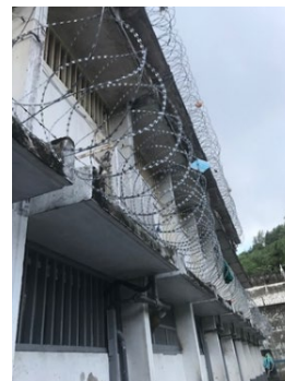
Vue du bâtiment depuis la cour du A
