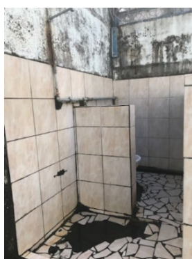
Point d'eau et sanitaire
