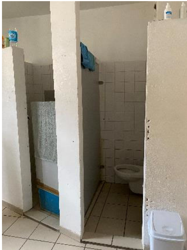
Sanitaires d'une cellule du quartier des arrivants
