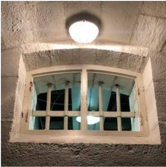
Le plafonnier de la première geôle
