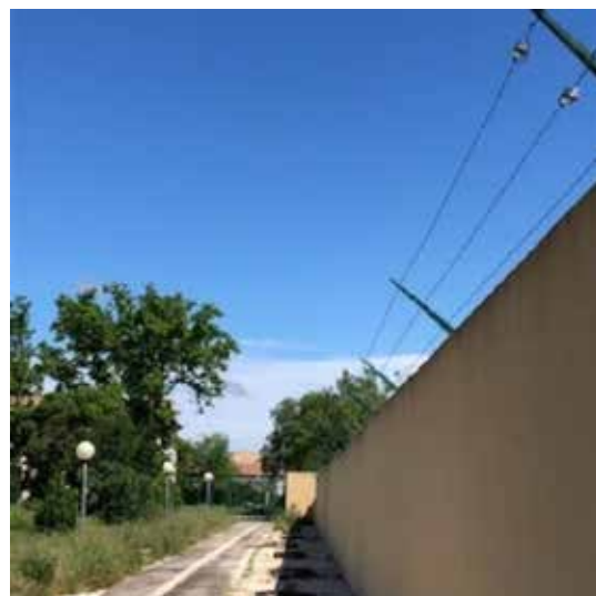
Le mur d'enceinte réhaussé et surmonté de trois rangées de barbelés clôt ce site qualifié d'alternative à l'incarcération
