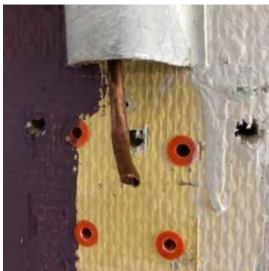
Un tuyau de cuivre apparent dans un espace de circulation
