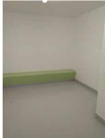
Vue d'une salle d'attente
