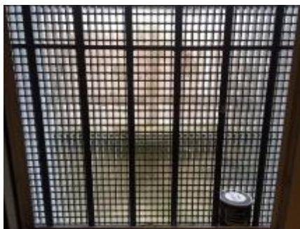
« Fenêtre » d'une cellule d'isolement
