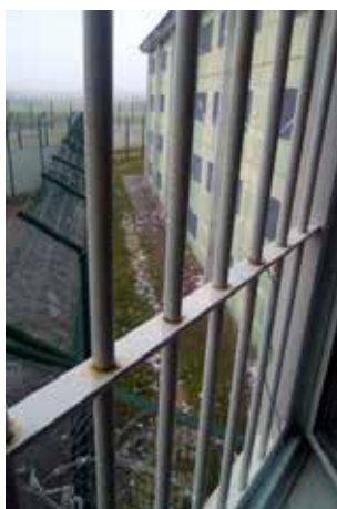
Abords d'une aile du bâtiment B
