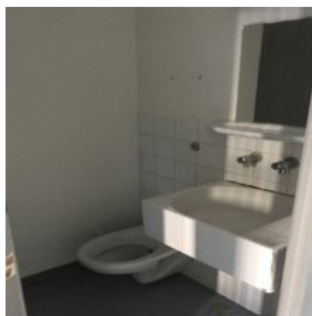
Sanitaires d'une cellule du QI
