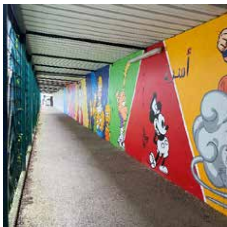
Couloir d'accès des visiteurs
