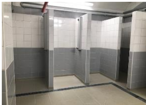
Douche commune du sous-sol
