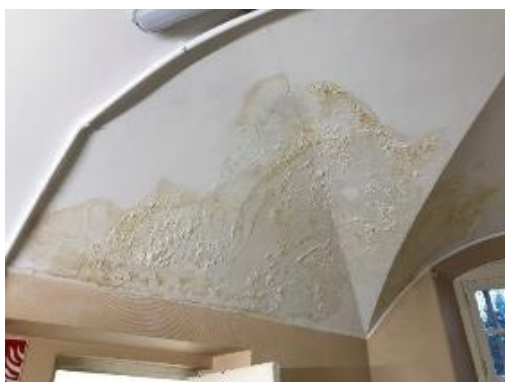
Plafond de l'unité sanitaire
