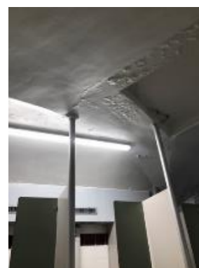
Plafond d'une douche commune
