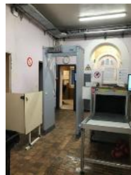
Zone du portique de détection
