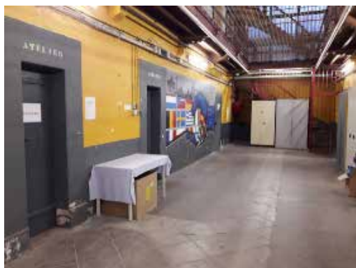
Vue de la coursive distribuant les ateliers
