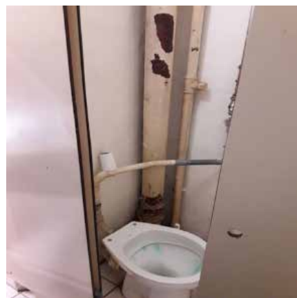
Lavabo et WC d'une cellule au QA
