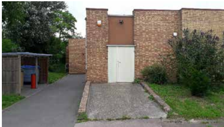
Porte latérale utilisée pour les personnes retenues
