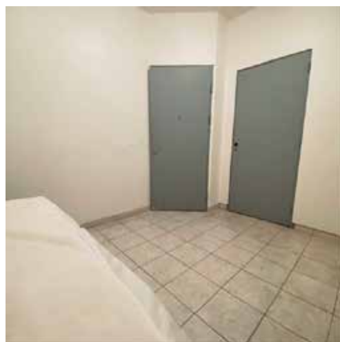
Cellule de retenue depuis l'intérieur
