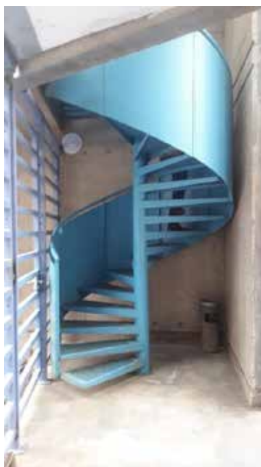
Escalier en colimaçon conduisant au dépôt depuis le parking
