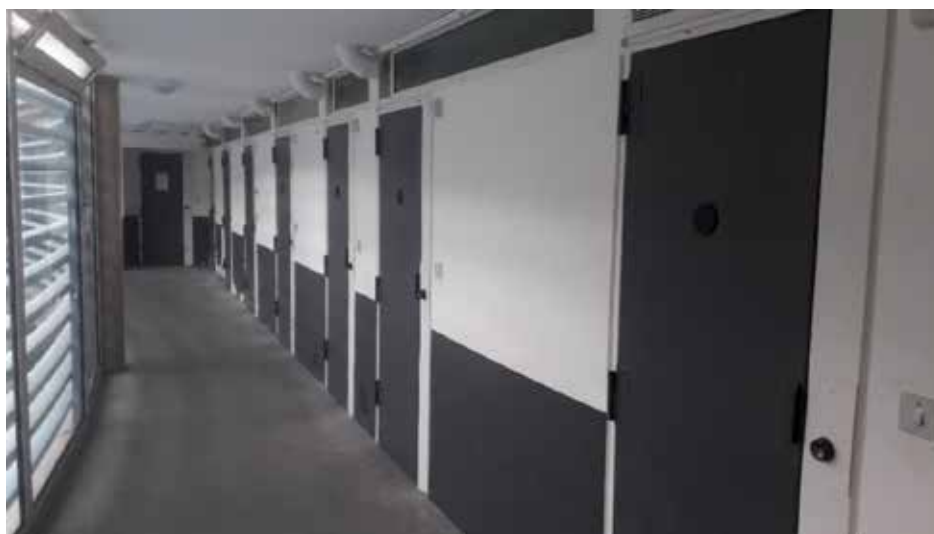
Le couloir du dépôt avec, à droite, les portes des cellules
