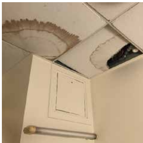
Le plafond de ce local
