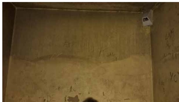
Mur de la cellule collective
