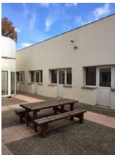
Cour intérieure aile Ouest
