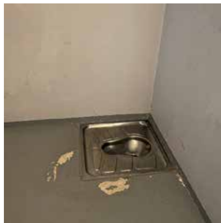
WC de la cellule n°3
