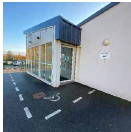
Entrée du sas piéton
