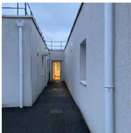
Passage d'accès pour les personnes interpellées
