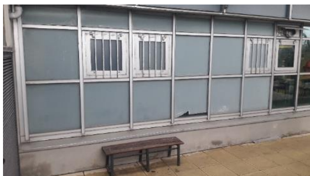
Les chambres vues de l'extérieur
