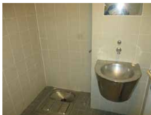
Une partie de la salle d'eau – la douche n'est pas visible
