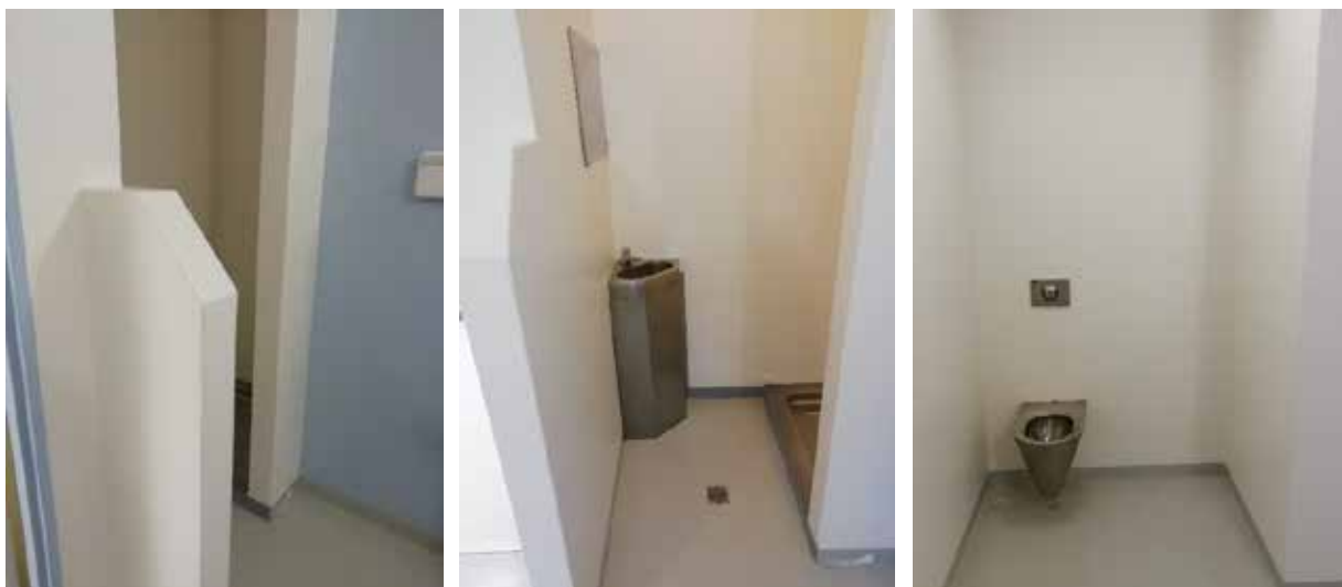
La vue sur la douche et les toilettes est protégée des regards
