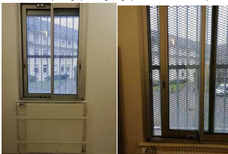
Fenêtre coulissante de la chambre sécurisée
