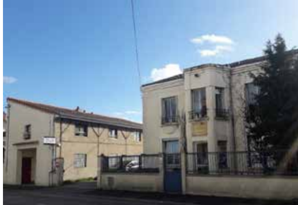
Le bâtiment principal - vue depuis la rue
