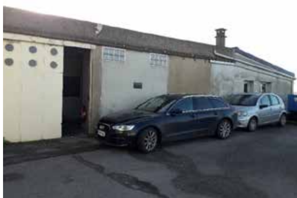
Les bâtiments annexes
