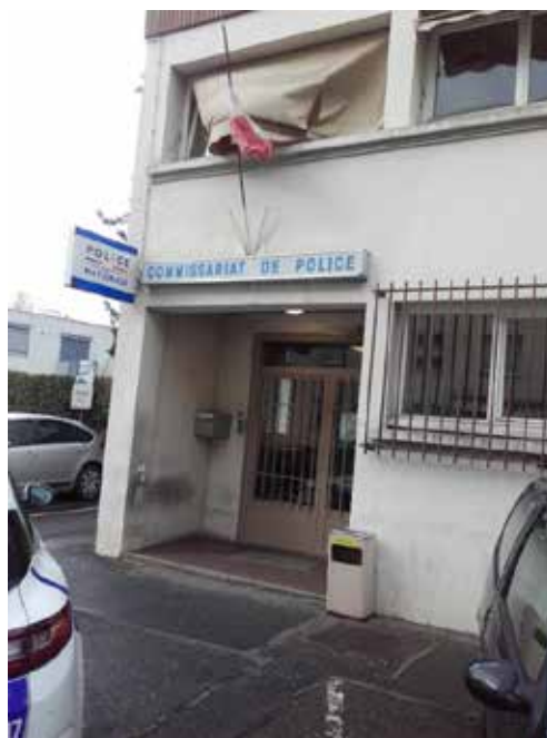
Entrée du commissariat
