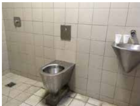
Les sanitaires dédiés aux GAV
