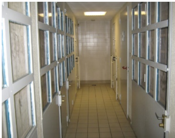
Le couloir desservant les cellules de garde à vue et les cellules de dégrisement
