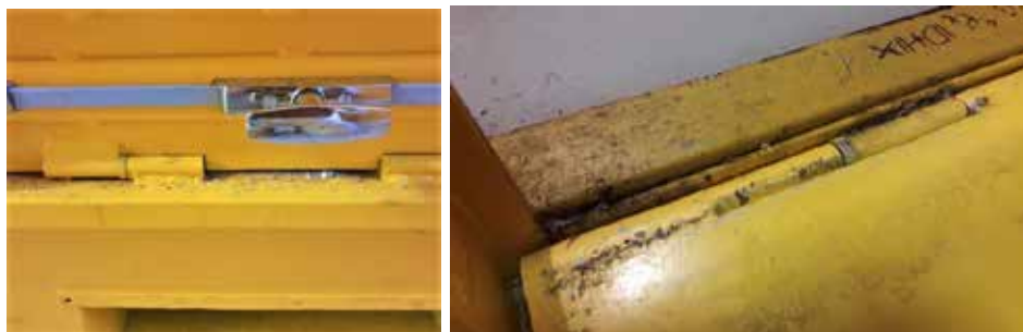
Passe-plat au bas d'une porte de cellule (position fermée / ouverte)
