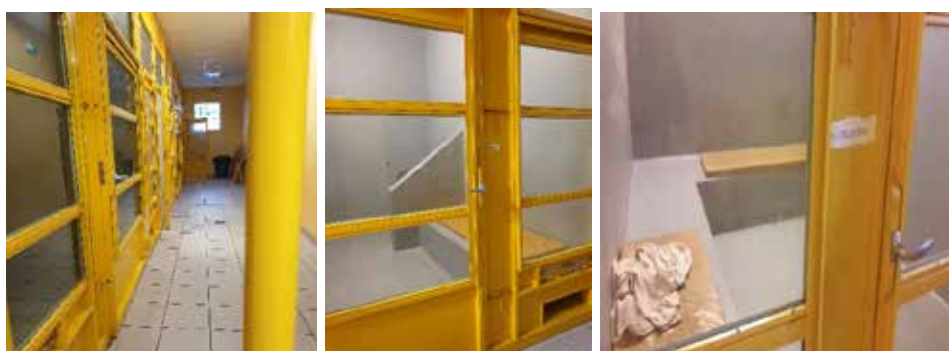
Accès à la zone de sûreté
