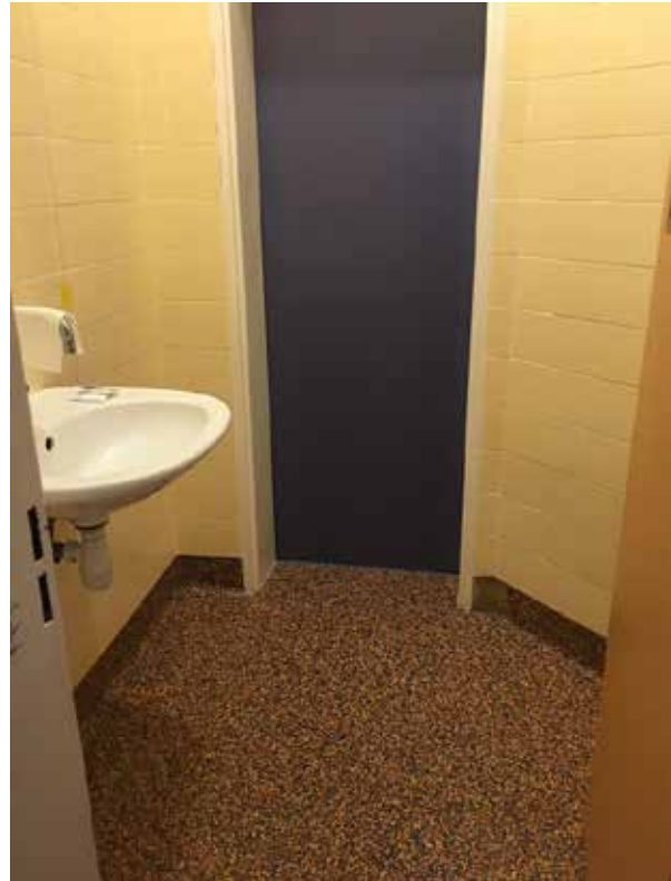
Salle d'eau de la CI de l'UHCD
