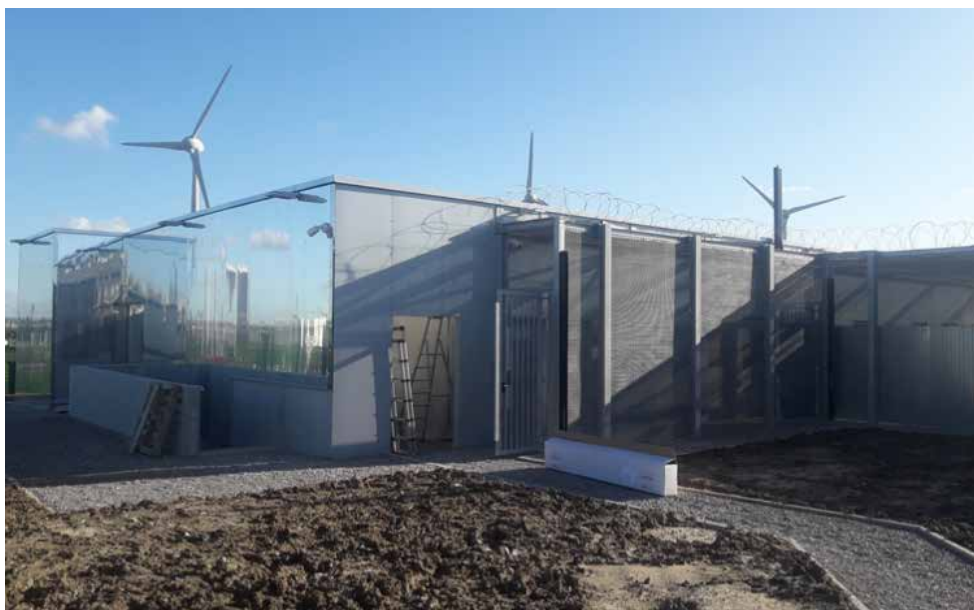
Le nouveau bâtiment d'hébergement depuis l'extérieur, inaccessible aux personnes retenues
