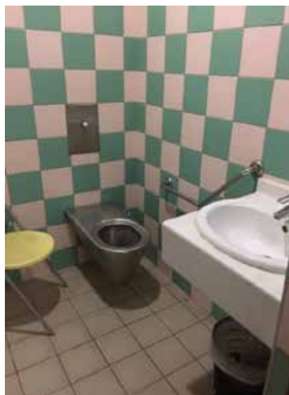
Salle d'eau contiguë à la chambre
