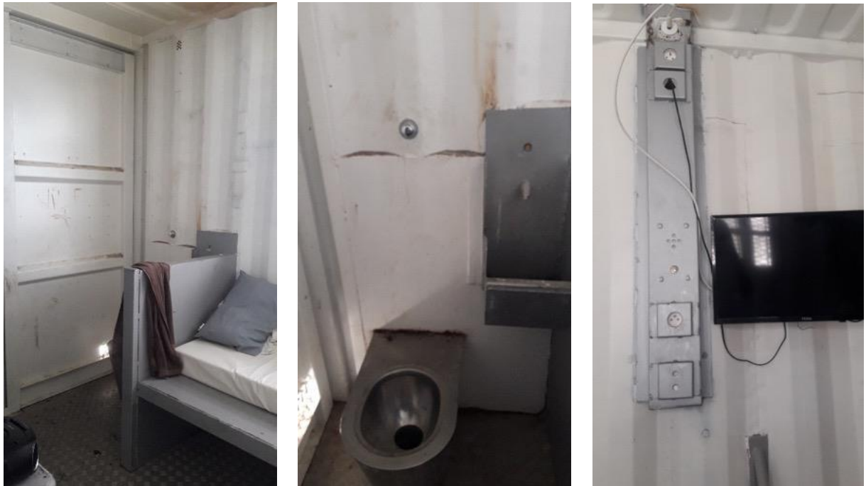
Cellules d'isolement ; à d., système électrique et d'interphonie
