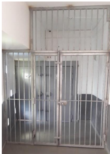
L'accès aux salles de classe, après leur transformation temporaire en cellules courant 2018
