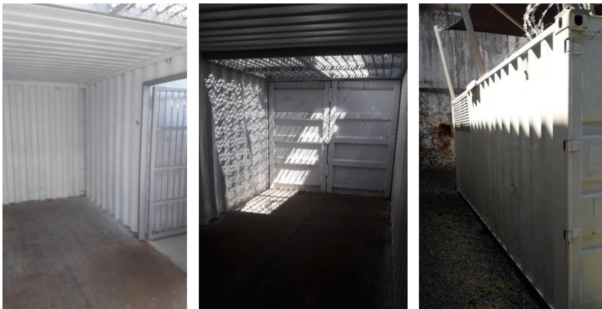
QD/QI : espaces dits de promenade ; à d., vue depuis l'extérieur
