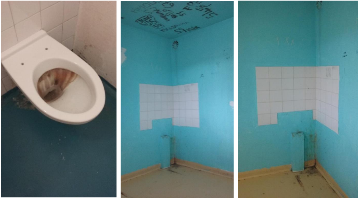
WC et salle d'attente de l'unité sanitaire
