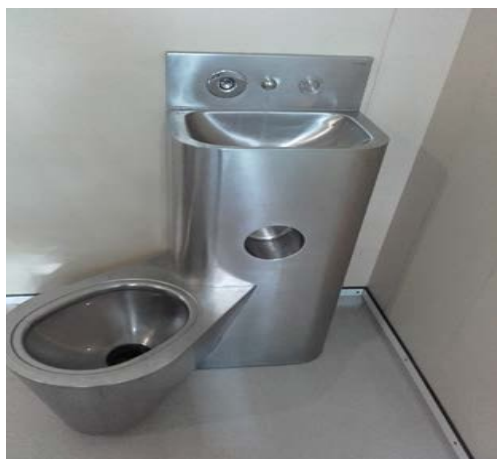
Bloc de WC et lavabo, unité Eole 1
