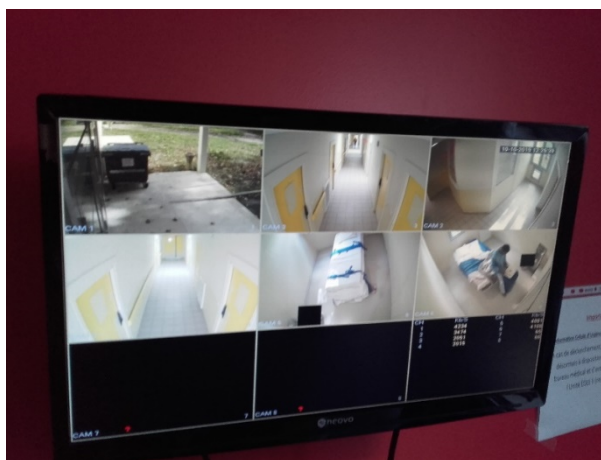
Ecran de report des images de vidéosurveillance dans le bureau infirmier de Eole 1 : extérieur, couloirs intérieurs, deux chambres d'isolement
