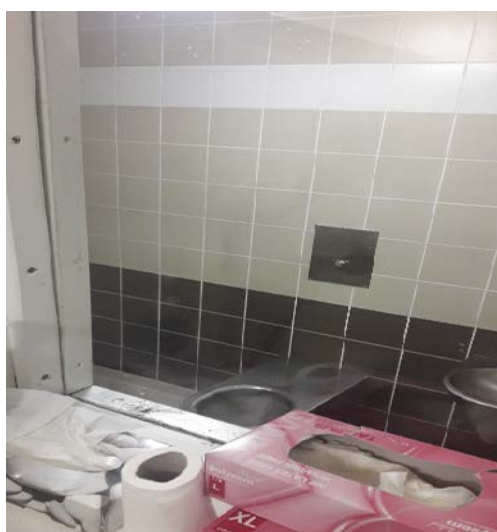
Fenestron du sas de l'unité G22
