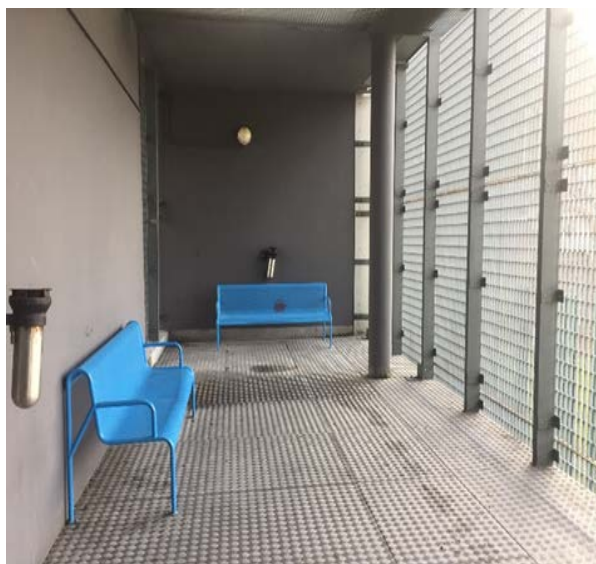
Terrasse grillagée 59G13
