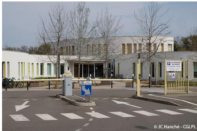
L'entrée de l'hôpital
