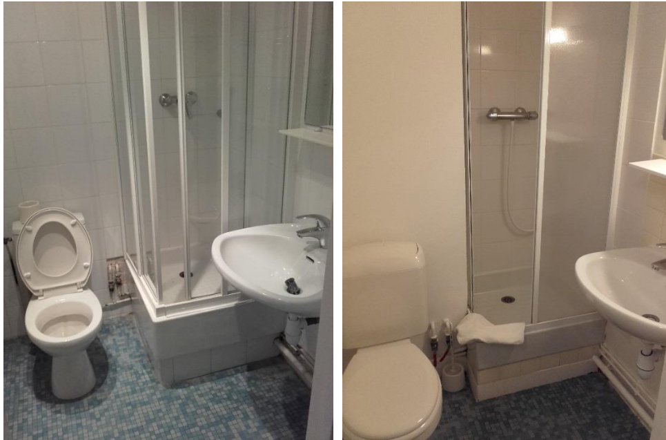
Salle d'eau à la résidence (à gauche) et à l'unité HTC1 (à droite)
