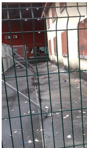
Rez-de-chaussée des unités palissades de protection
