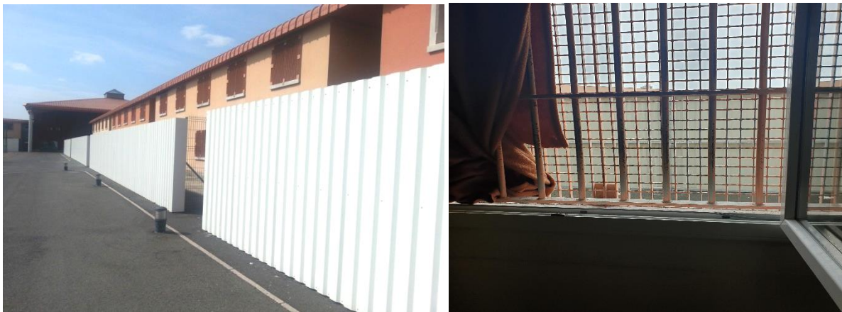
Les palissades installées devant les unités Fenêtre d'un rez-de-chaussée
